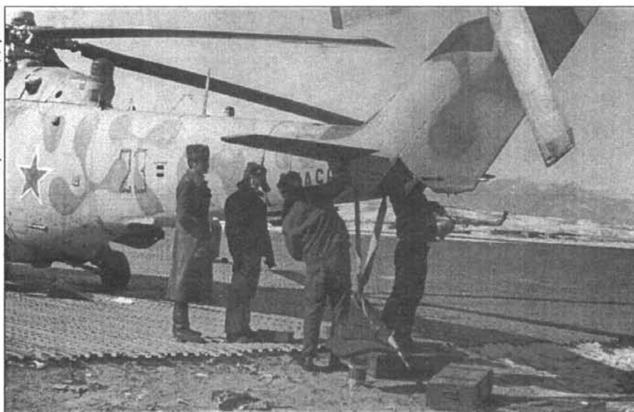
Замена килевой балки. Газни, зима 1985-86 гг.
