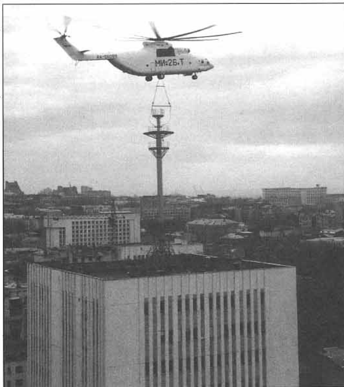
Установка вышки ретранслятора на крышу ростовского центрального телеграфа. Декабрь 1995 г.
