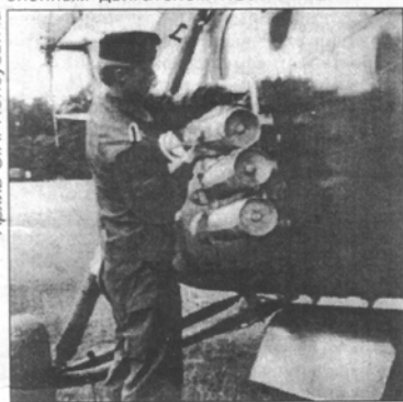
Подвеска глубинных бомб на Ми-4МЭ. Видны раскрытые створки бомболока
