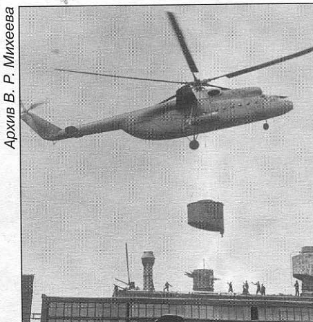
Ми-6 выполняет краново-монтажные работы
